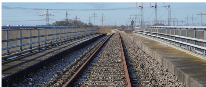
Figur 16: Järnvägsbron över Yttre ringväg.
