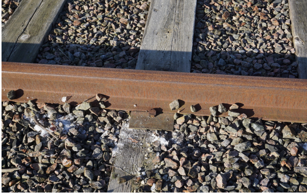
Figur 11: Spikbefästning
