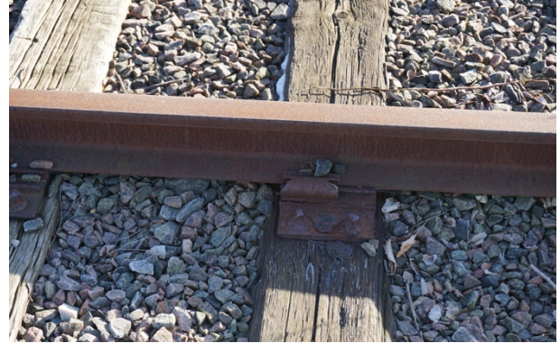
Figur 12: Heyback befästning
