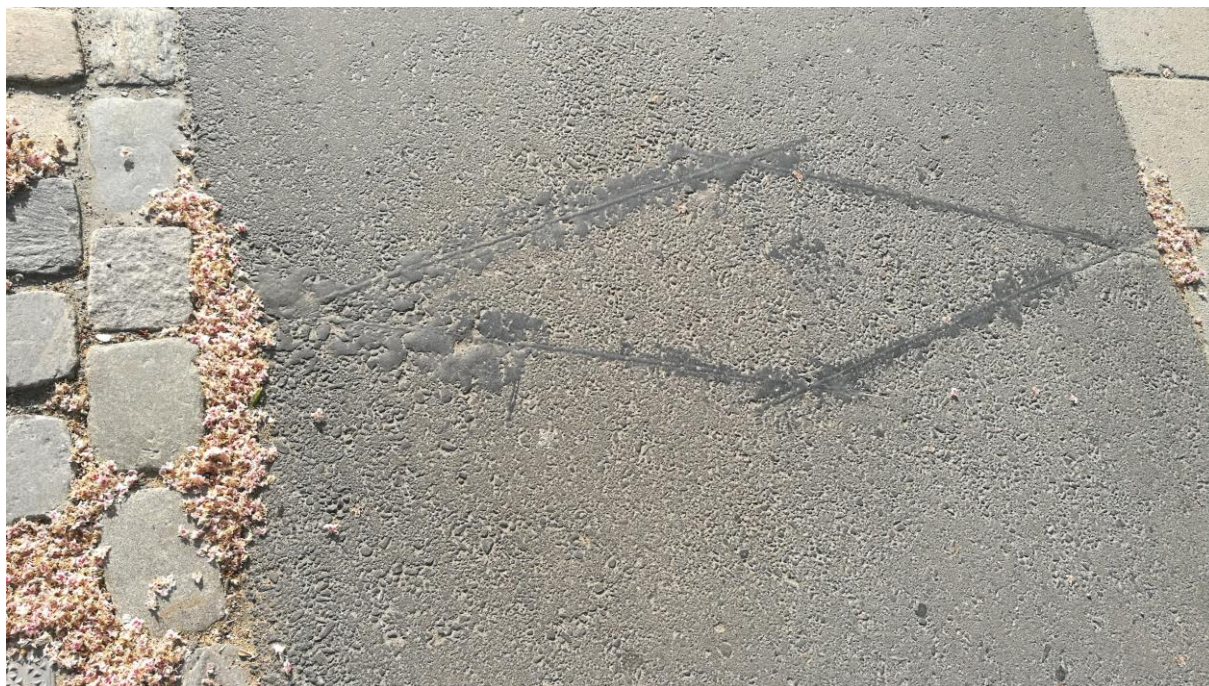
Bild: Dold cykelräknare på Trollebergsvägen
