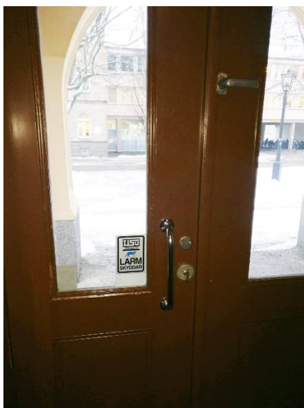
Figur 22. Foto på besöksentré. Högra dörren är utrustad med svärmanövrerat beslag.
