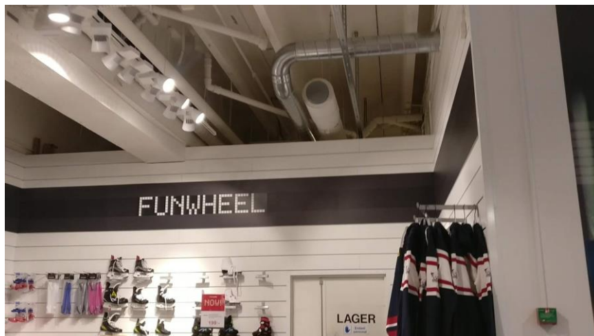
Figur 40. Öppning ovanför skiljeväggen mellan Intersports lager och butik.
