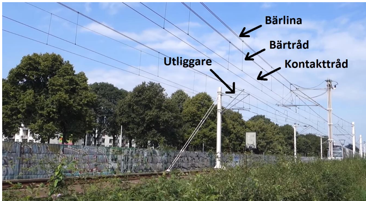
Figur 9.2 Beskrivning för kontaktledningens olika komponenter (Källa: Mazerolles 2018 c, förändrad av författare).
