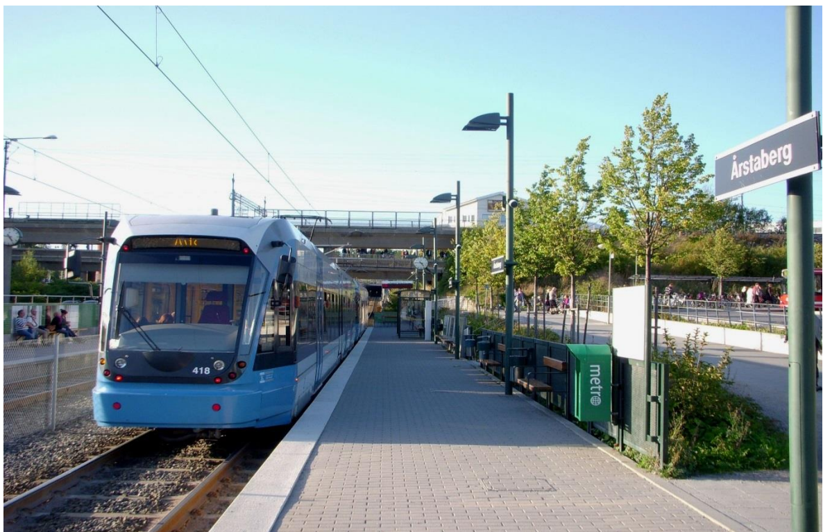
Figur 5.3 Exempel på spår på egen banvall. Tvärbanan, Stockholm (Källa: Wikipedia 2009 a)
