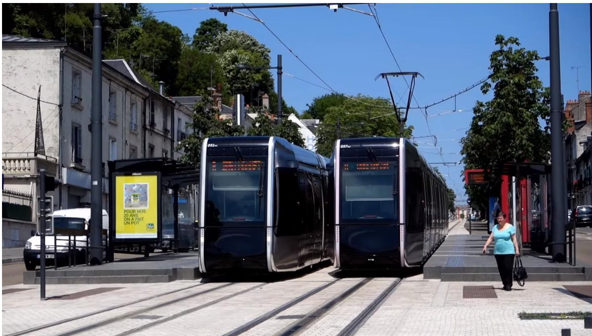
Figur 8.2 Enkel och öppen spårvagnshållplats i franska staden Tours (Källa: Mazerolles 2015).
