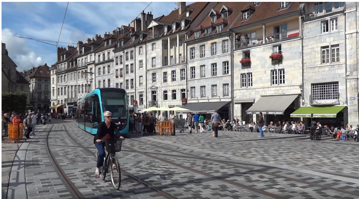
Figur 9.4 Spårväg i Besançon, Frankrike. Hög kontaktledningshöjd i samband med att kontaktledningen fästs i bärlinor mellan byggfästen medför att kontaktledningen smälter in och gör ett litet visuellt intryck i stadsmiljön (Källa: Mazerolles 2014).
