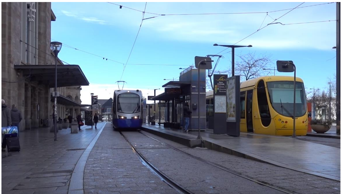
Figur 9.3 Exempel på kontakttråd som fäst i bärlina som sitter fast mellan en stolpe och en byggnad i Mulhouse, Frankrike. (Källa: Mazerolles 2018 a).
