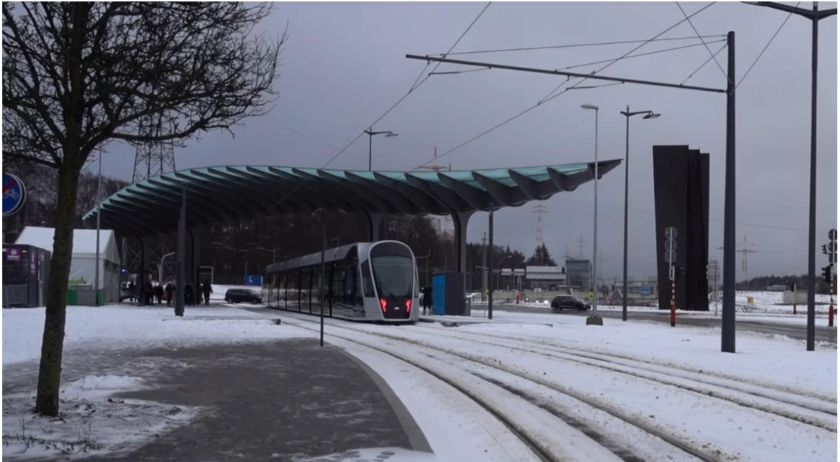
Figur 8.3 Hållplats i Luxemburg, Tyskland. (Källa: Mazerolles, B 2017c).
