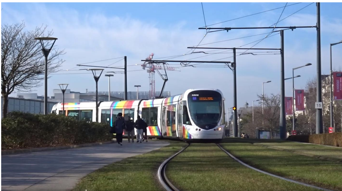
Figur 4.1 Spårväg i Angers, Frankrike. Spårväg i gräsplantering medför mer grönska i staden (Källa: Mazerolles 2017 b)
