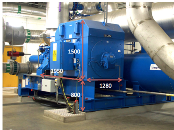
Figur 4.1. Elmotorns dimensioner. Mått angivna i mm.
