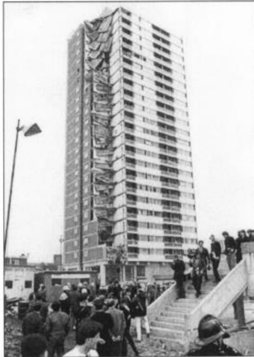
Figur 1 Ronan Point lägenhetshus efter raset (Pearson & Delatte 2005).
