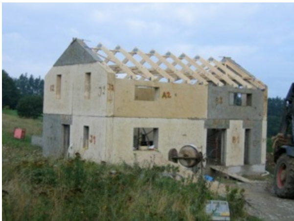
Figure 21. The Trällit Helvägg construction on site (Source: http://www.nikearkitektur.se/nike_arkitektur/Valkommen.html )
