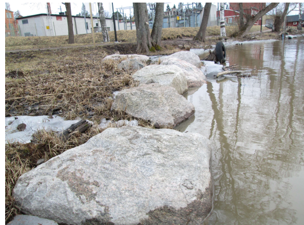
FOTOGRAFI 8 EROSIONSSKYDD PÅ VÄSTRA DELEN AV TEGELUDDEN DEPONI (20180407).
