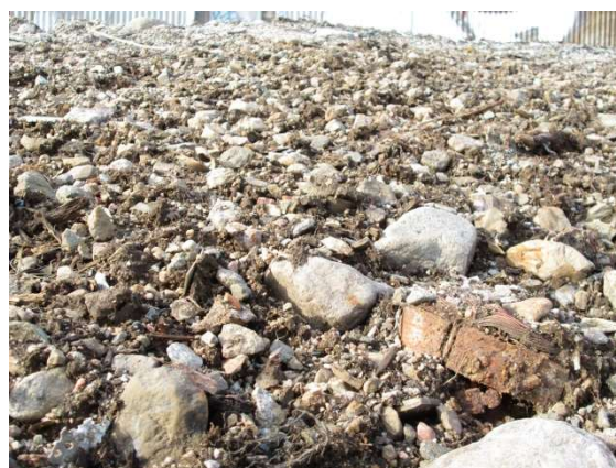
FOTOGRAFI 17 LÄTTARE MARKEROSION I DE OTÄCKTA FYLLNADSMASSORNA PÅ ARBOGA BYGG & MASKINTEKNIK, I SYDÖSTRA HÖRNET AV FASTIGHETEN (180407).
