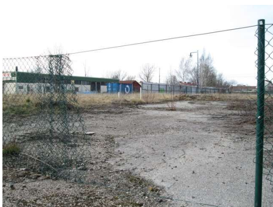
FOTOGRAFI 16 UPPKLIPPT STÄNGSEL INTILL INGÅNGEN PÅ ARBOGA BYGG & MASKINTEKNIK, TAGET FRÅN SÖDRA SIDAN AV FASTIGHETEN. INGEN VARNINGSTEXT GES VID OBJEKTET (180407).
