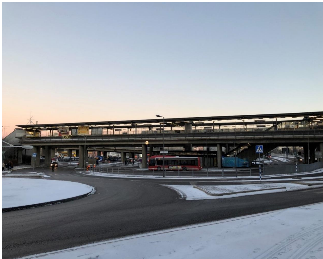
Ropsten tunnelbanestation, Norra Djurgårdsstaden
