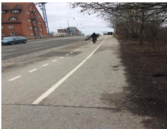
Figur 6 Bron över järnvägen
