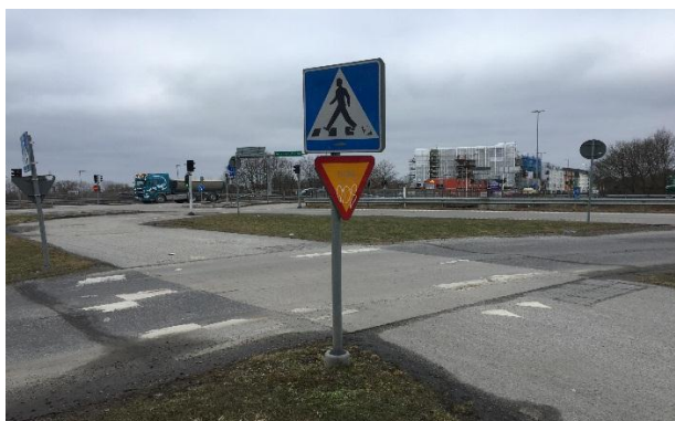
Figur 11 Övergångsställe vid korsningen med E22
