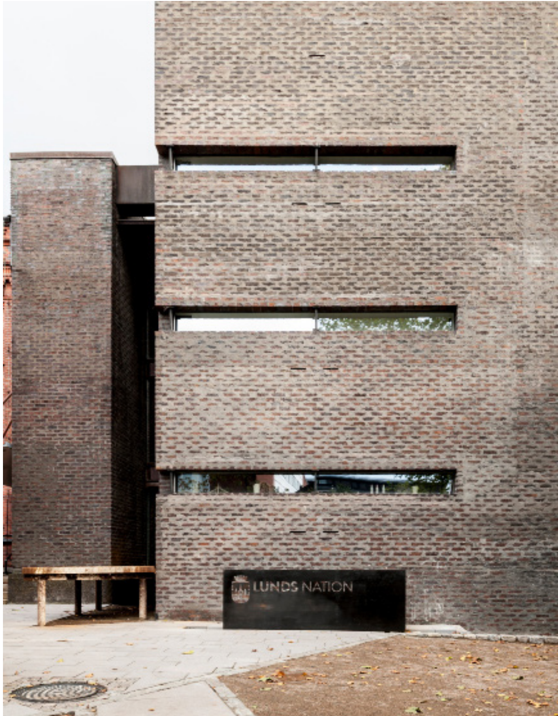
Före detta landsarkivets annexbyggnad i Lund. Bernt Nyberg 1971 Foto: Nilsson 2014
