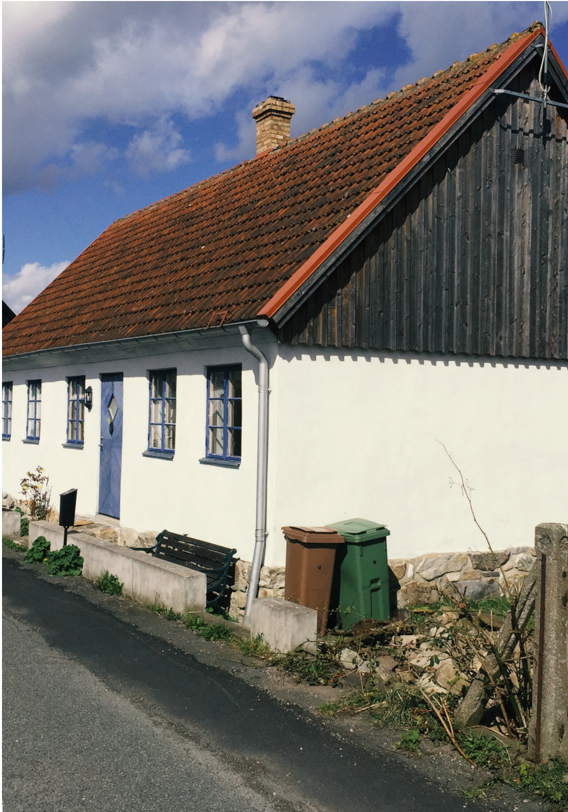
Detta smala hus har en något utstickande takfot och hängränna som håller ned den upplevda höjden på långsidornas fasader.
