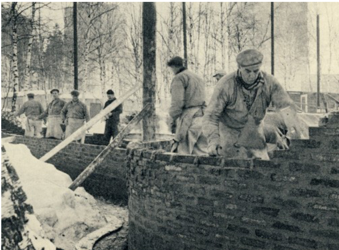
Sigurd Lewerentz Markuskyrka murades med breda stötfogar och med ett rått, något utdraget fogbruk. (Okänd fotograf 1960)
