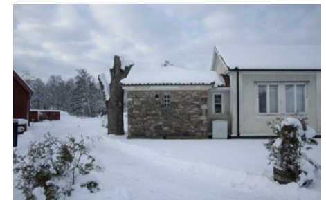
Nedan: Det gamla kassavalvet vid byggnadens södra ände.
