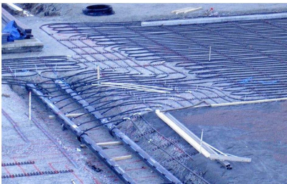
Figur 3: En förläggning av markvärme i Malmö (LK Systems 2018)
