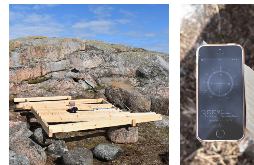
VITÖREN BESÖK 2, UTPLACERING OCH MONTERING AV GRUNDKONSTRUKTIONEN
