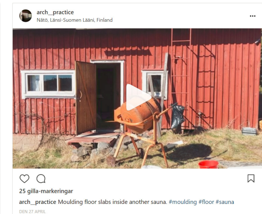
GJUTNING AV BETONGPLANK
