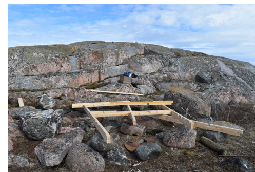
VITÖREN BESÖK 2, UTPLACERING OCH MONTERING AV GRUNDKONSTRUKTIONEN
