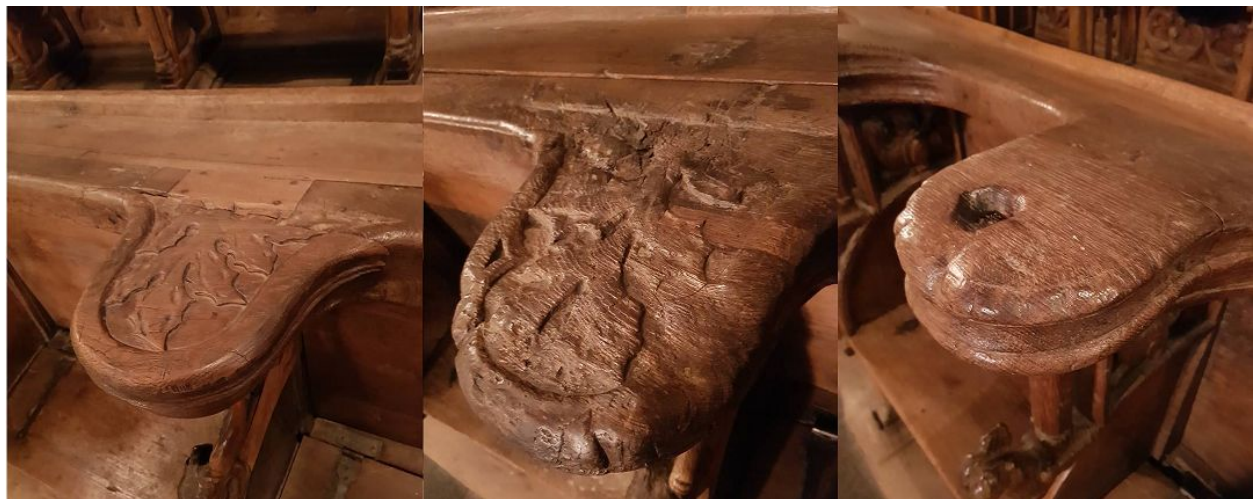
Figur 9. Olika grader av slitage på armstöden vittnar om användning. Noterat att längst till vänster är en replik. De andra två är original. 01-12-2018.
