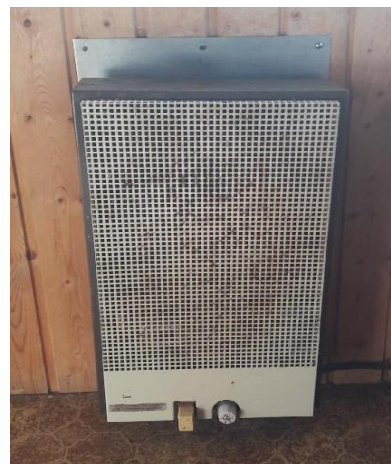
Figur 8 - Gasoelement som används för uppvärmning i Kårsavagge. Fotograf: Nordin, 2018.
