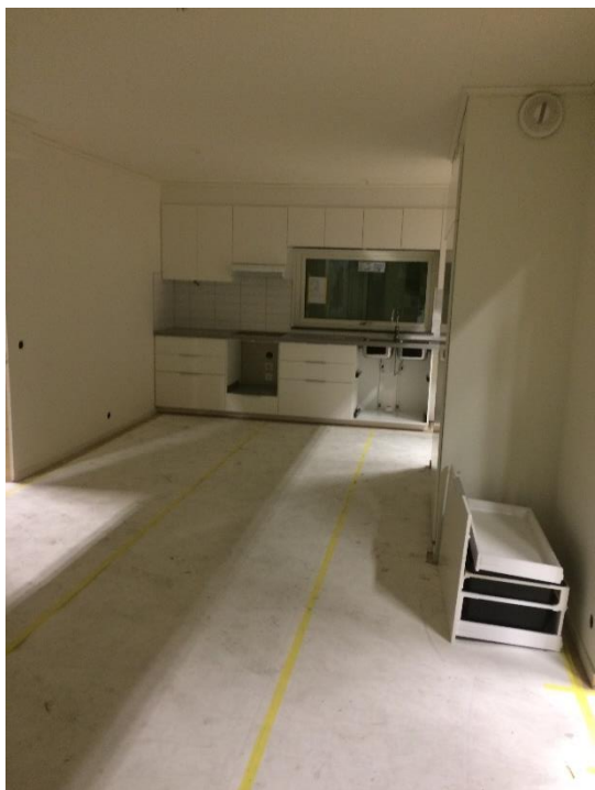
Figur 20. Inuti en köksmodul under konstruktion
