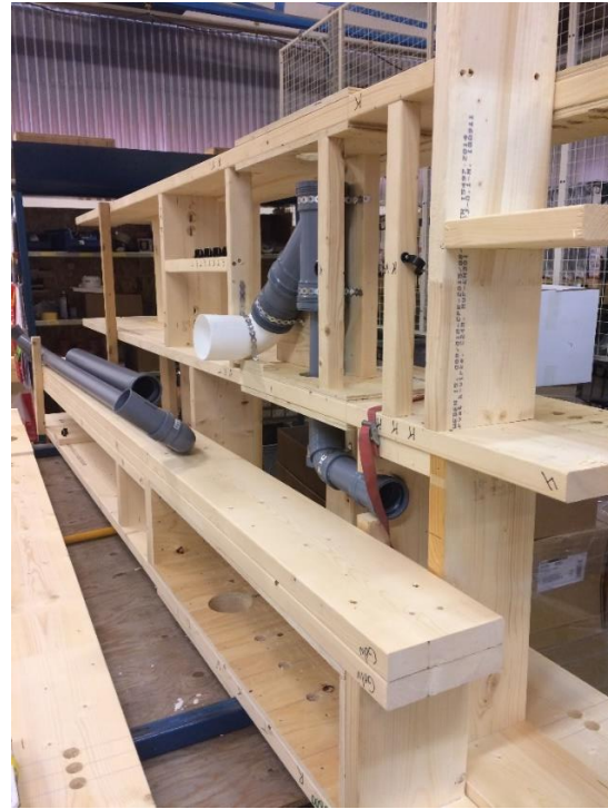
Figur 18. En del av golvet under köksbänken som är klart för montering.
