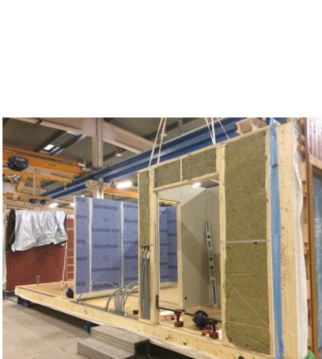
Figur 21. Montering av vägg i början av hall 17.
