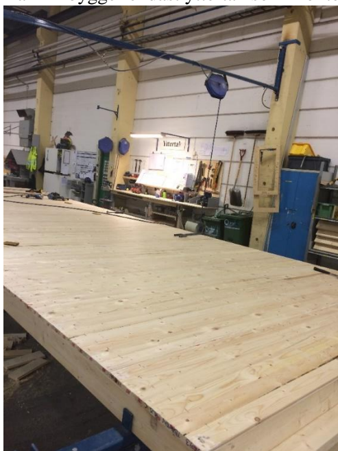
Figur 22. Yttertak i konstruktion i hall 22.
