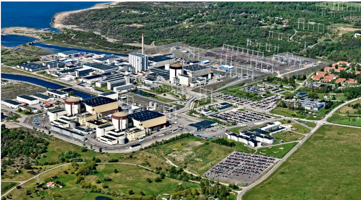
Figur 1 visar Ringhals kärnkraftverk med reaktor 1 och 2 i bakgrunden samt reaktor 3 och 4 i förgrunden (Vattenfall, ud).
