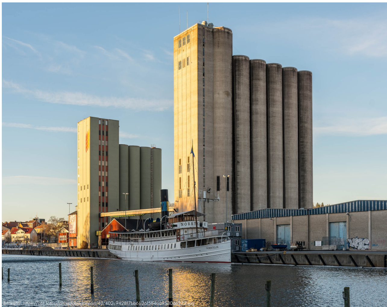
Ovan: Silos i norrtäljehamn, nu rivna Nedan: Kvarnholmens silo innan rivning
