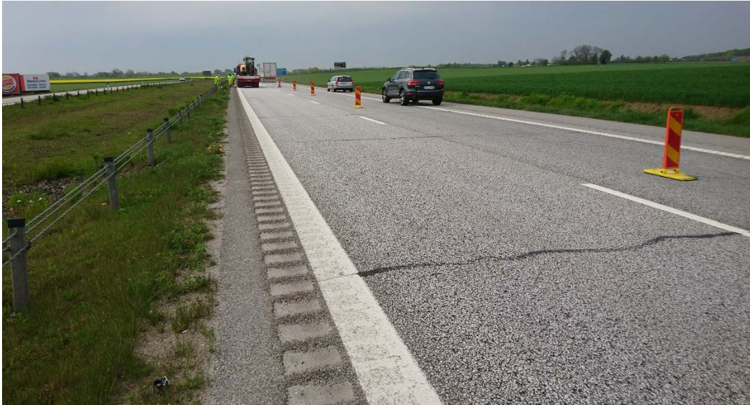
Figur 11. Utmärkning av vägarbetsplats E6 Sunnanå – Sallerup.
