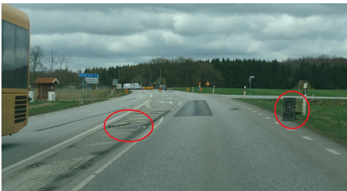
Figur 9. Väg 108, norrgående. Båda varningsskyltarna för vägarbete är defekta.
