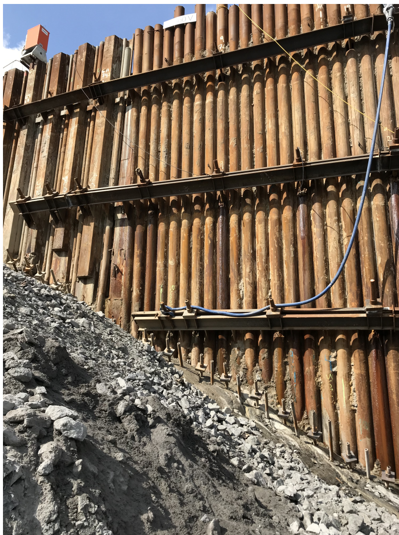
Figur 2.2: RD-pålvägg från Förbifart Stockholm, notera att entreprenören bytt från vibrodriven U-spont till RD-pålvägg till vänster i bilden.
