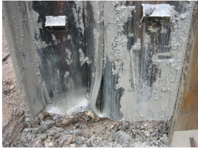
Figur 2.3: Skadad spontfot, från Guillemet (2013). Foto: K. Viking.
