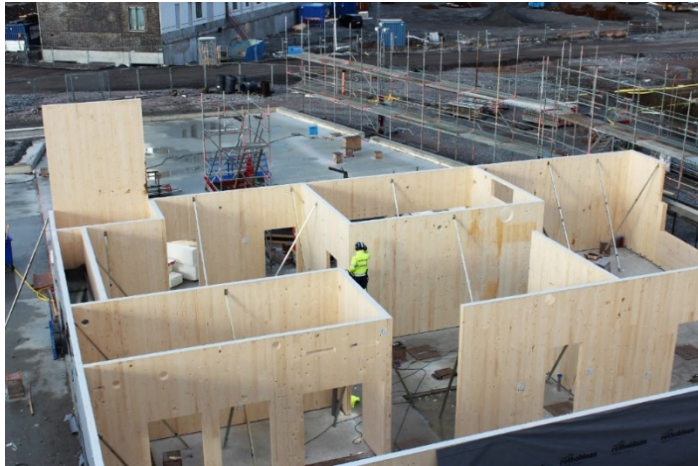
Figur 5.3 Herrestadsskolan under produktion. Montering av KL-trästomme (Olausson 2019).
