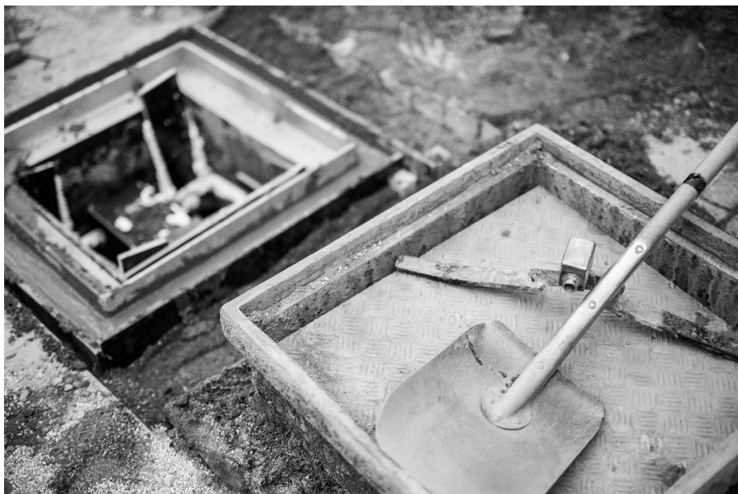
En vanligt förekommande ÄTA är oförutsedda arbeten i mark. Flera respondenter anger denna som en av de mest kostsamma ÄTA som uppkommer. Foto Stefan Casspe.
