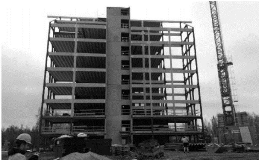
Figur 3.3: Bild tagen under resning av stomme. Bild tillhandahållen av WSP.
