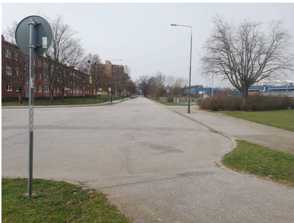
Figur 12: Exempel på osammanhängande bebyggelsestruktur i området runt Rosengårds station med bostäder till vänster och industriområde till höger i bild (Hammarberg, 2019).
