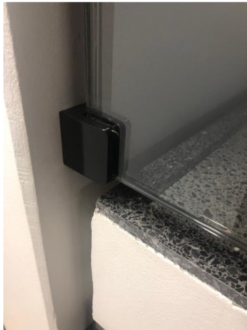
Figur 2.6 Exempel på glasklämma från sidan.
