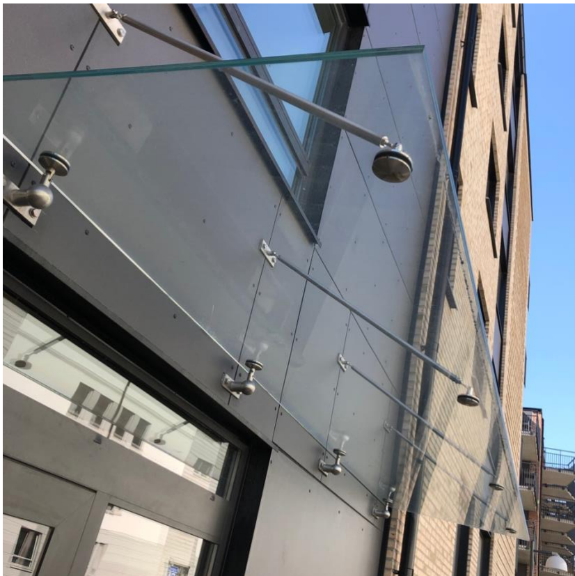
Figur 4.7 Bild på skärmtaket underifrån.
