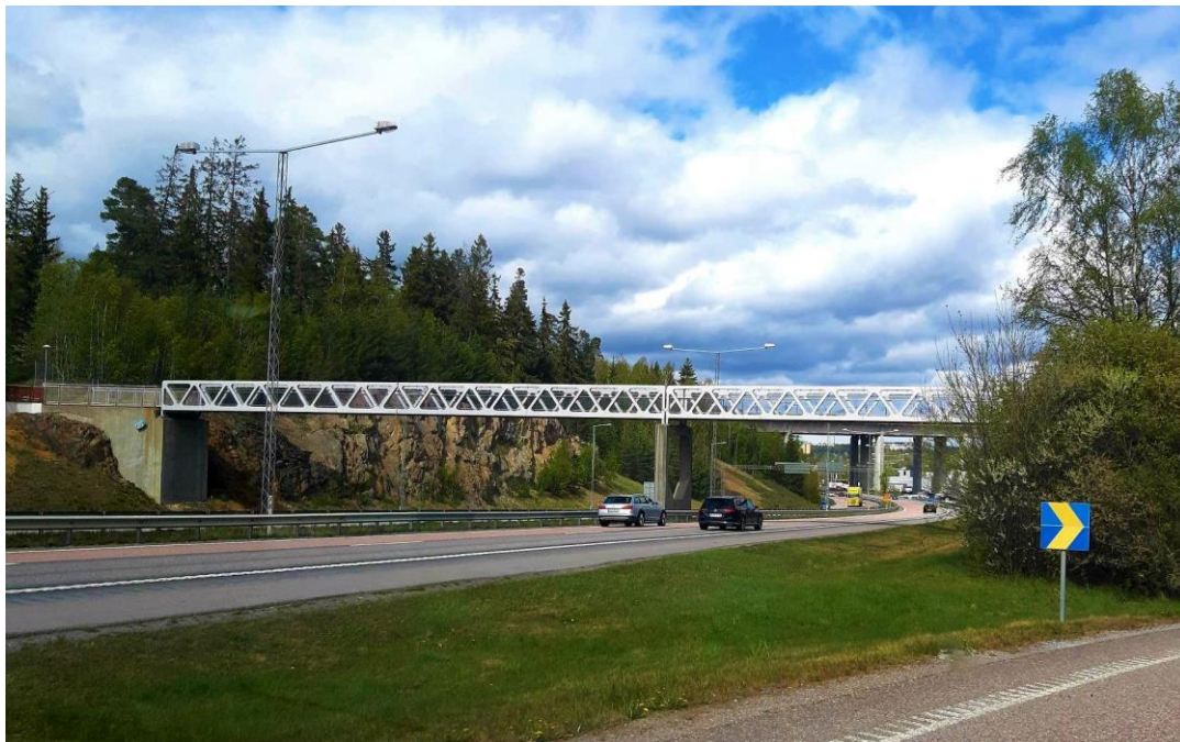
Figur 2.1 Existerande exemplar av den rostfria bron vid trafikplats Södertälje Syd
