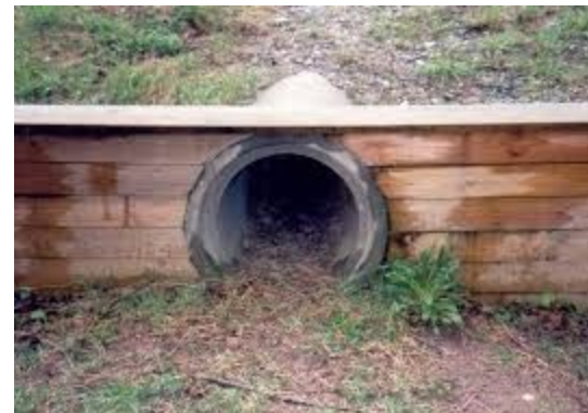
Figur 4 Grodtunnel med ledstaket.
