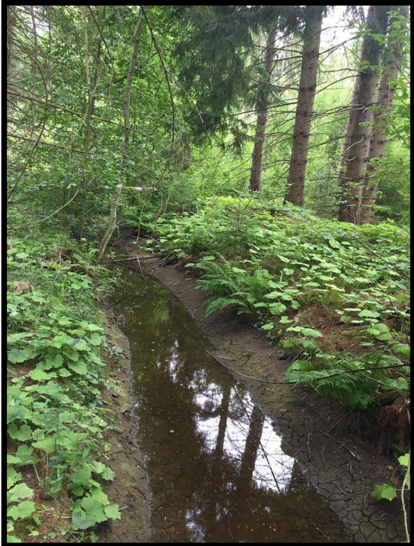
Figur 6. Elkabel vid sträcka 8 som har lossnat från stolpen och ligger i vattnet.
