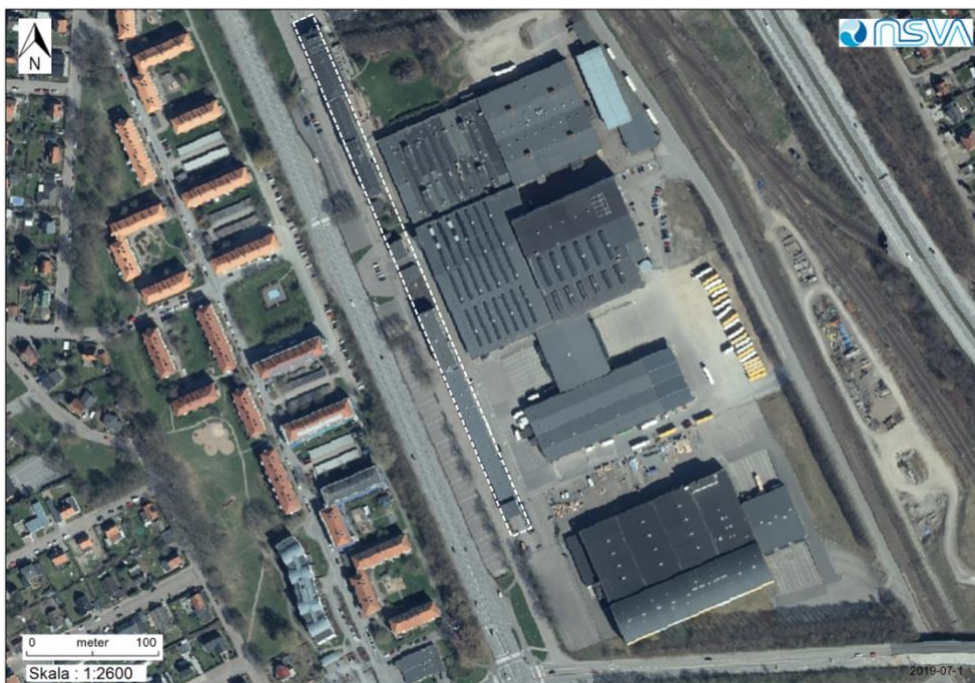
Figur 33. Den ungefär 200 m långa byggnaden med stuprör som leder regnvatten direkt till ledningsnätet är markerad med vit streckad linje. (VA- banken, 2019)
