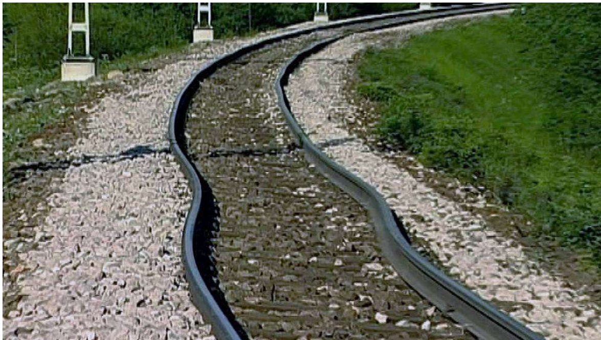
Figur 1. Spåret har en lokal utknäckning innan en kurva, alltså en solkurva. Källa: SVT 2018a
