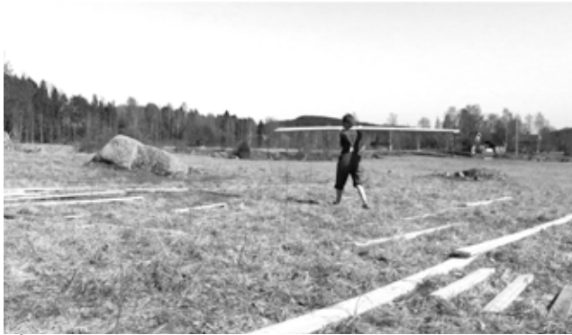
Sågar till plankor i olika dimensioner och bygger upp ett ramverk.
