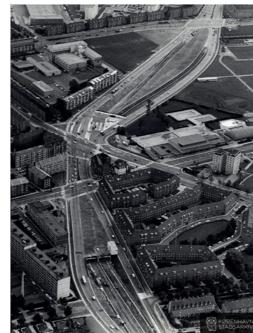
Frederikssundsvejstunnel in 1969. Source: Københavns Stadsarkiv, 1969
