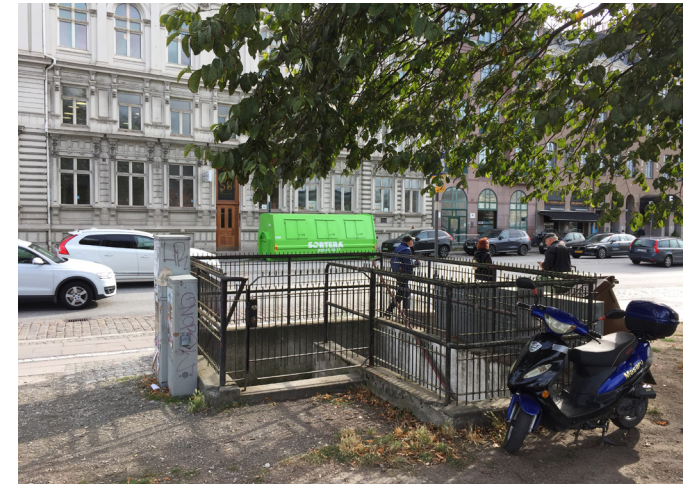
Näst intill busshållplatserna finns trappan ner till skyddsrummet, omgärdat av metallstaket och elskåp.
