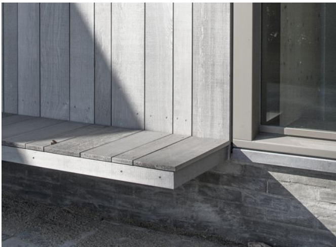
Figur 8. Fasad med utskjutande bänk i nivå med fönster.
