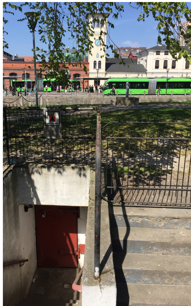
Trappan ner till skyddsrummet, som tidigare var ett hål rakt ner i marken, täckts i den nya gestaltningen över med en öppningsbar plattform i sitthöjd.
