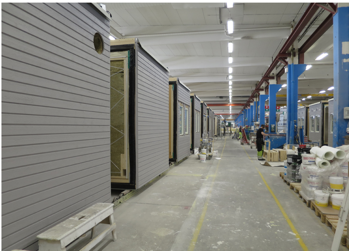
Avslutande målning av färdiga volymelement vid Moelven byggmoduls fabrik i Sandsjöfors.
