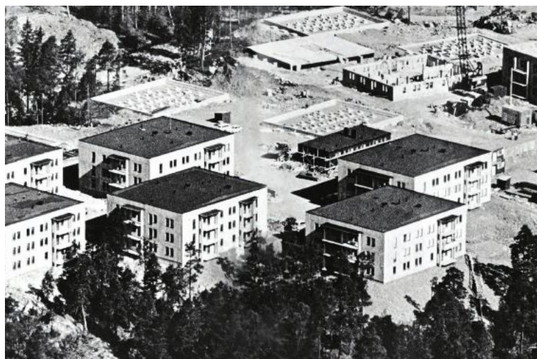
Exempel på bostäder producerade med system Skarne 66. Västra Orminge, 1964. Bild: E Stenberg
