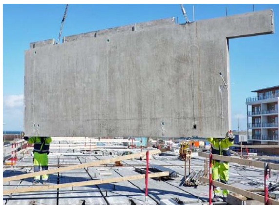
Figur 2 Väggelementet förs på plats. Lyftet sker med hjälp av lyftkrokar som är fastsatta i elementet (ByggAi, 2008a).
