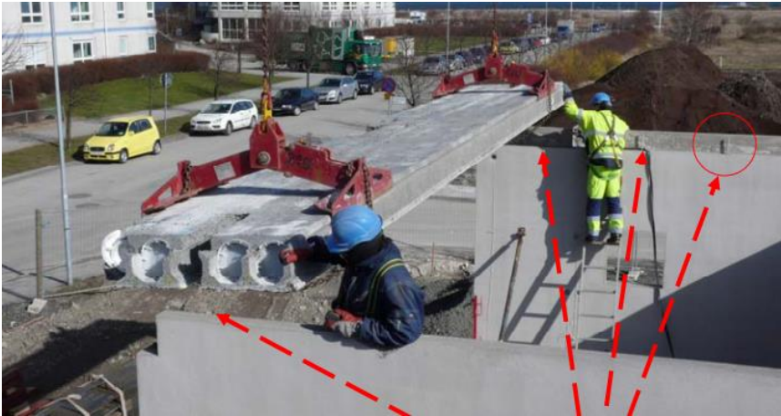
Figur 5 Håldäcket sänks ned på förankringsdubbar som pilarna pekar på i bilden (ByggAi, 2008a).
