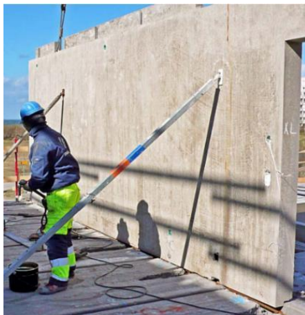
Figur 3 Stråvor stabiliserar väggelementet till dess att alla element är på plats, sammankopplade med varandra och gjutning av skarvarna har gjorts (ByggAi, 2008a).
