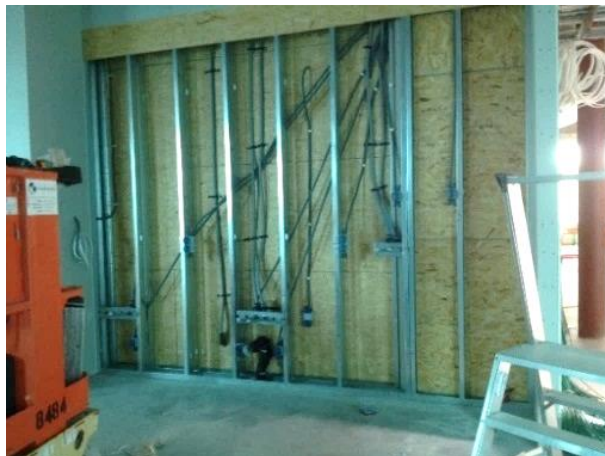
Figur 11 Installationsvägg (innervägg) uppreglad med stålreglar, mellan relgarna dras elinstallationer.
