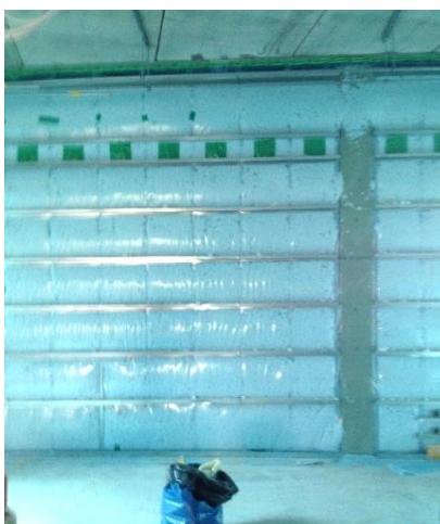
Figur 12 Platsbyggt yttrevägg (utfackningsvägg) som fyllts med lösull. Stålreglar fästs på insidan av plastfolien och skapar ett skikt där installationer kan dras utan att göra hål i plastfolien. Efter att installationerna dragits placeras ytterligare isolering mellan stålreglarna.
