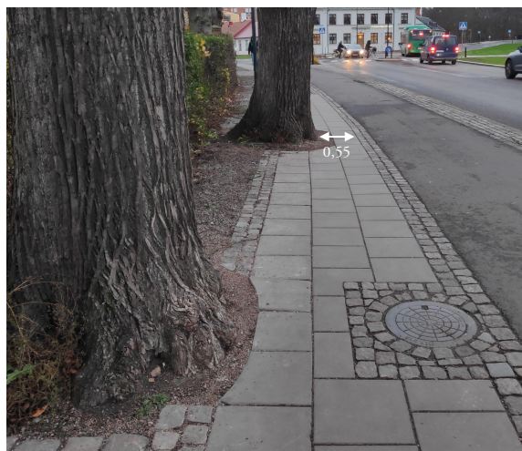
Figur 39. Avsmalningar på gångbana vid trädplanteringar på Bredgatan. Foto: Petter Streiffert
