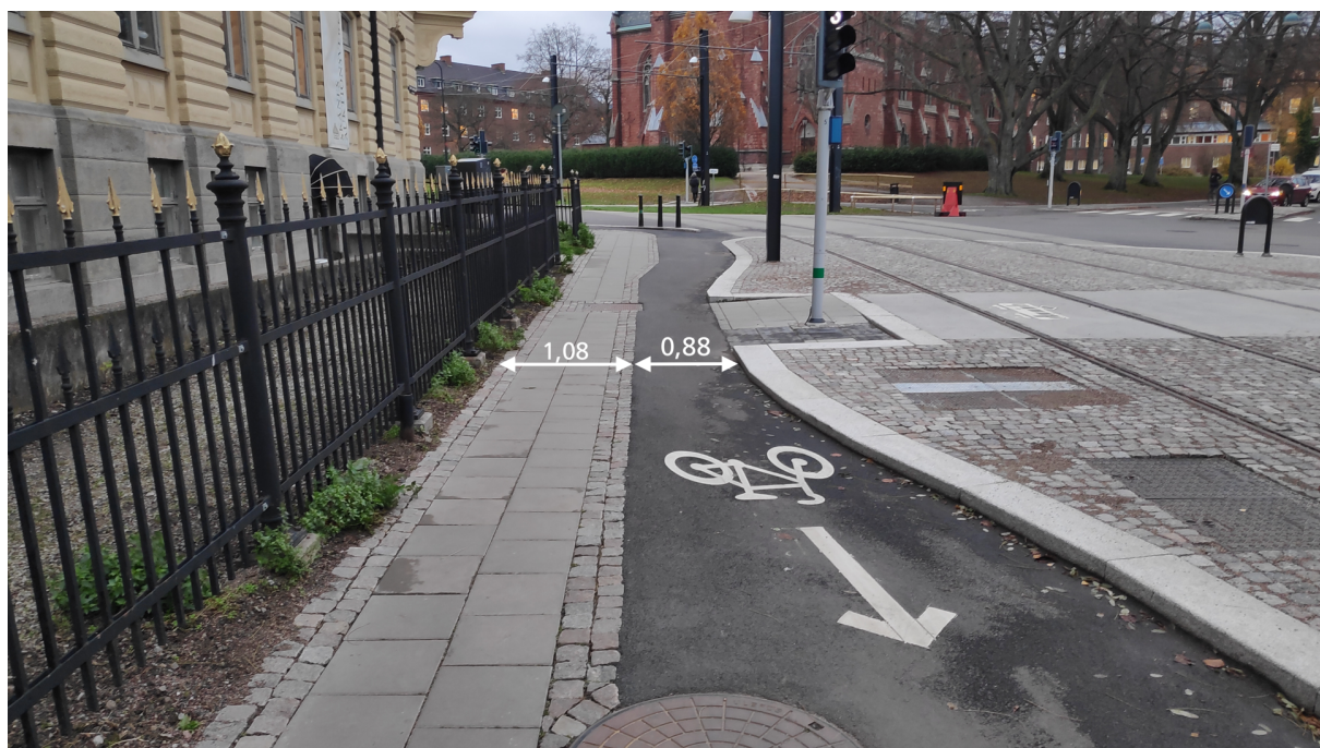
Figur 38 Avsmalning på gång- och cykelbana vid St. Laurentiigatan. Foto: Petter Streiffert
