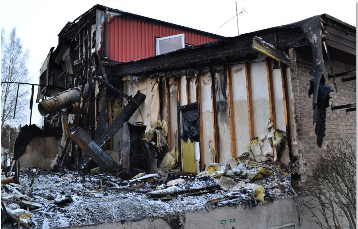
Fotografi 8: Bildexempel från en brand skolfasad, där branden spridit sig till tak- och vindkonstruktion innan räddningstjänstens ankomst. Bildkälla anges ej.
