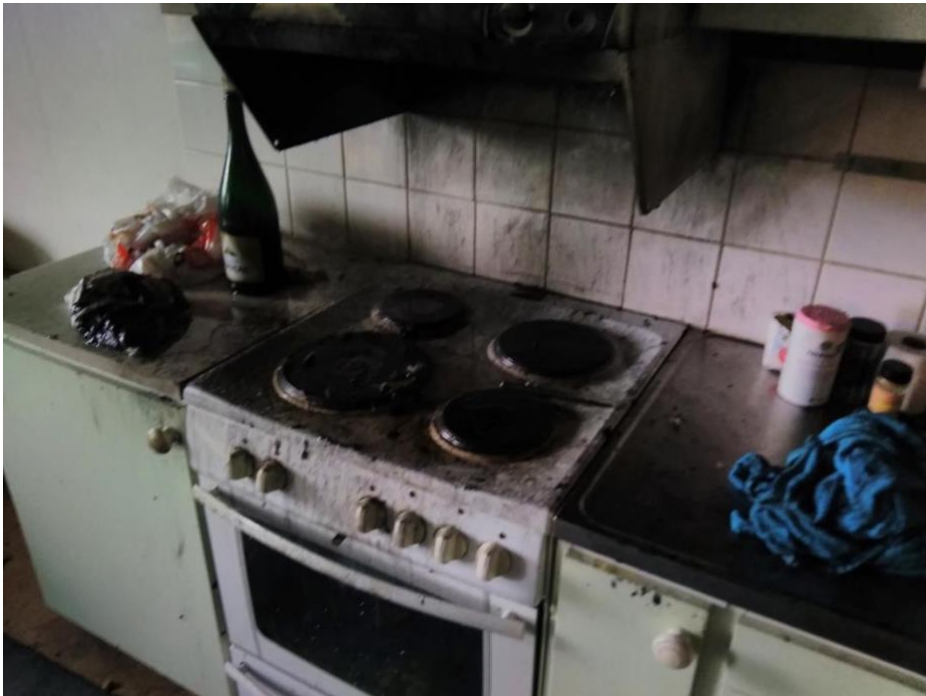
Fotografi 9: Bildexempel från en spisbrand som släckt i ett tidigt skede. Föremål som befunnit sig på spisen under branden har tagits bort. Notera även att det finns sot- och smältskador på spisfläkten som är svåra att se.
