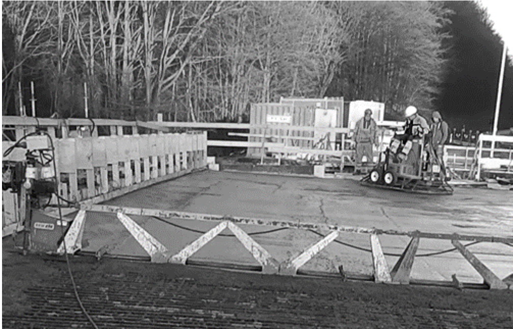
Figur 22. Visar en åkglättare som bearbetar betongytan till en tät och slät yta.
