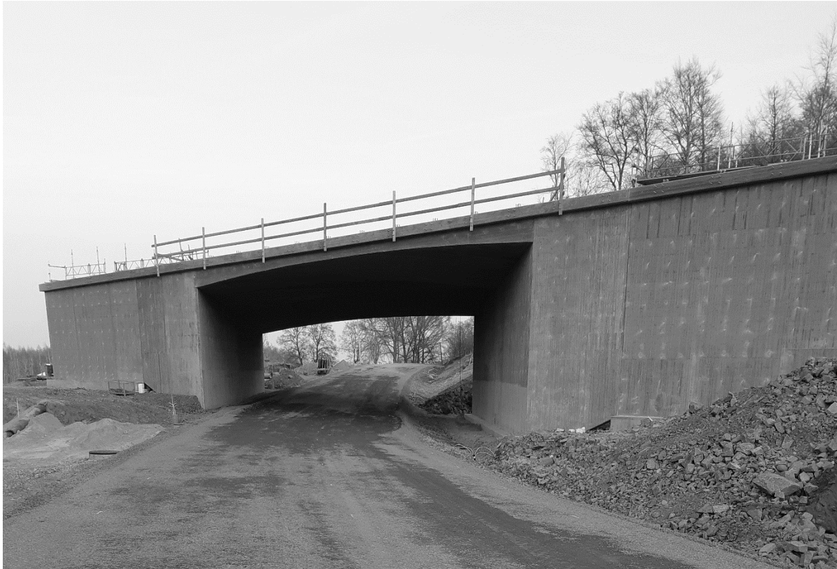
Figur 24. Visar bro 4 färdiggjuten sett från landsvägen som går under motorvägen.
