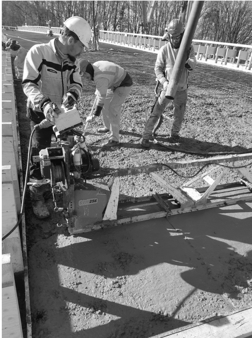
Figur 21. Visar en fackverksbrygga som vibrerar och avjämnar betongytan.
