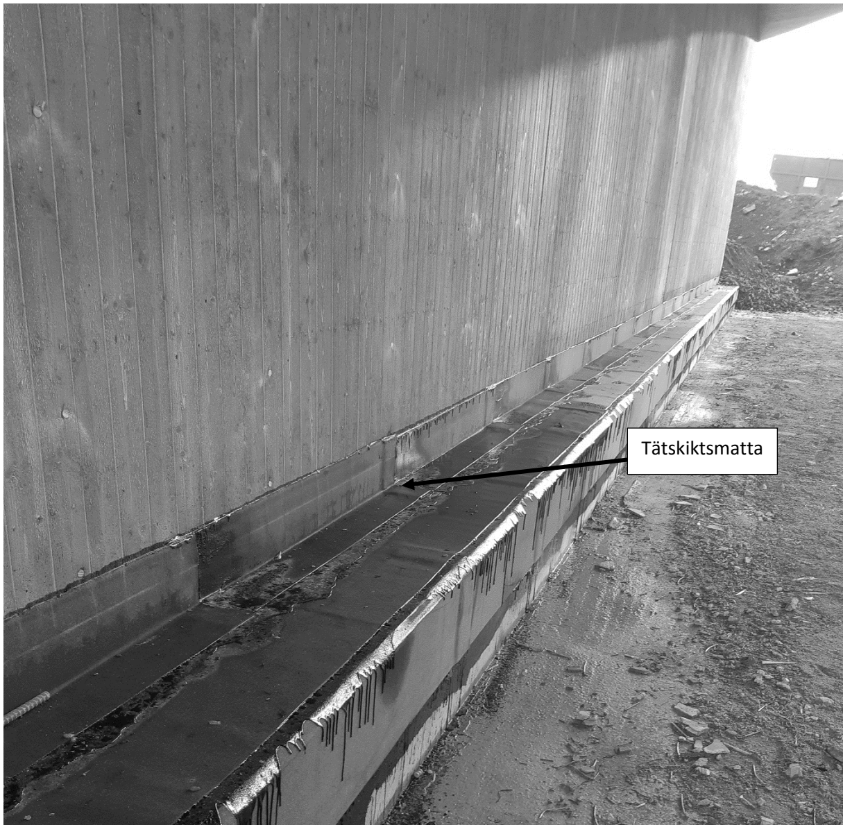
Figur 45. Visar insidan av ramben där inga synliga sprickor syntes.
