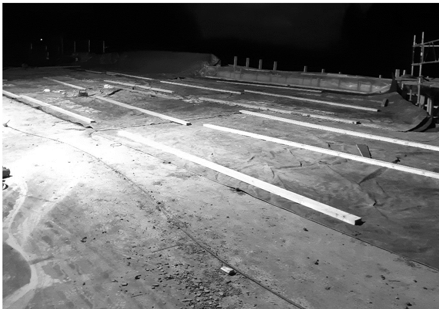
Figur 23. Visar täckningen av betongytan av etapp 2 på bro 4.
