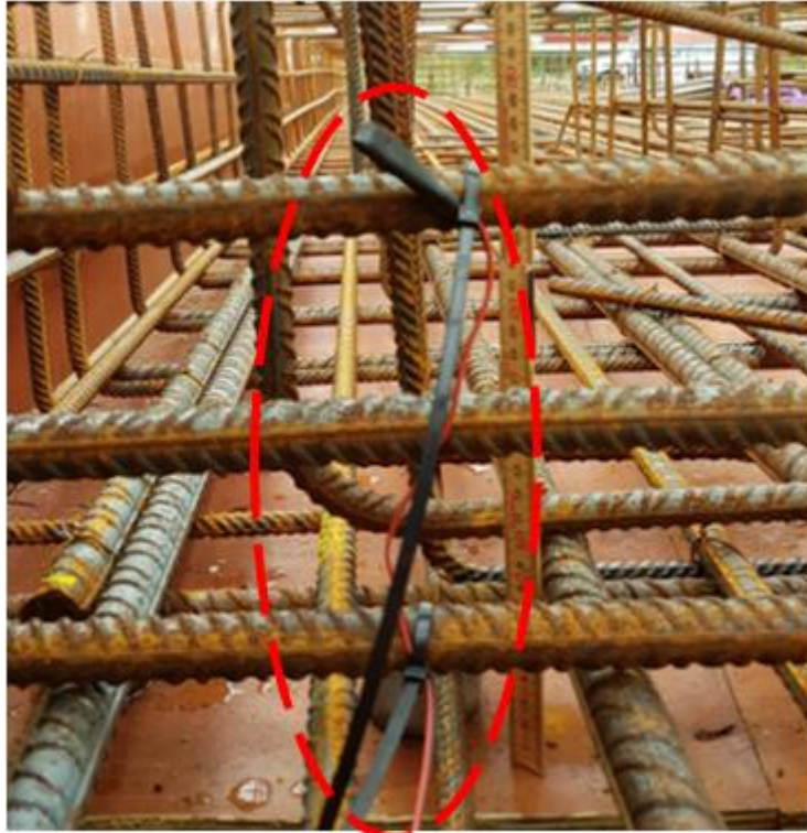
Figur 26. Visar en temperaturgivare med isolering och infäst i armeringen med buntband.
