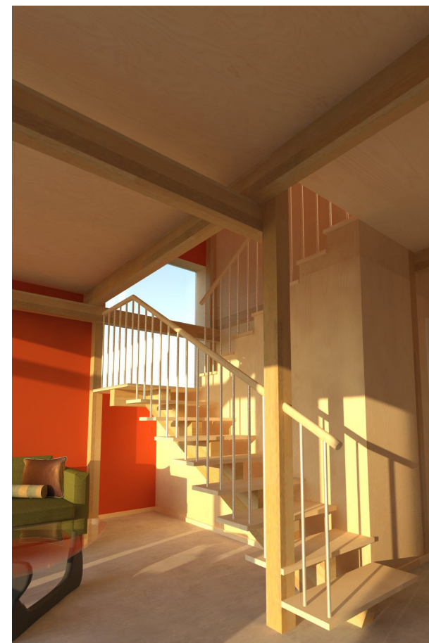
Fig 14: Det inre bärverket sätts samman i med pluggar i knutarna likt Rietvelds Red and Blue Chair.
