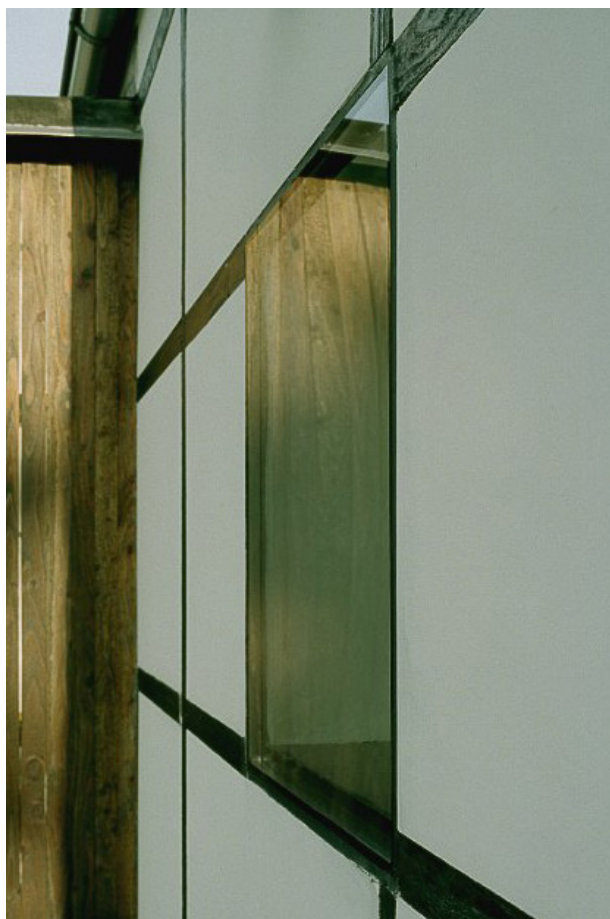
Fig 11: Fönsterkassetter monterade direkt i fasaden med hjälp av mjukfog (Bild: Kreark)
