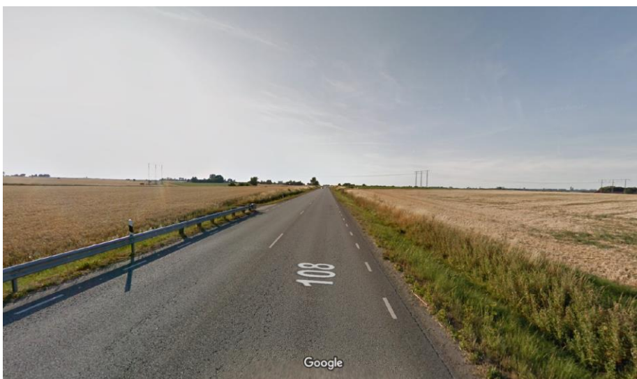
Figur 6. Väg 108 strax utanför Staffanstorps med vy i riktning mot Lund (hämtad från Google maps 2020-02-20).
