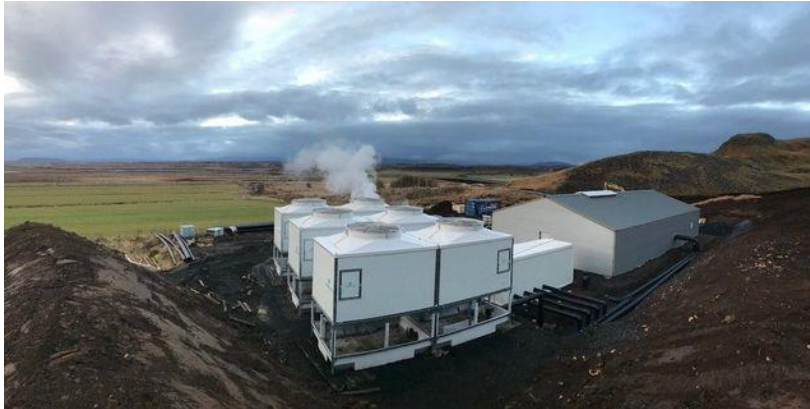
Figur 1: Climeons ORC-kraftverk producerar här el från geotermisk värme på Island
