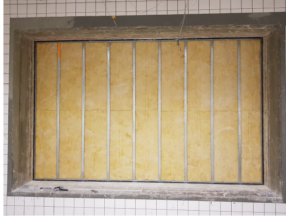
Figur 3.19: Montering av glasull för vägg med ljudklass R'w=52 dB.
