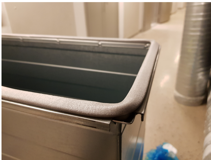
Figur 3.16: Koppling för det rektangulära kanalsystemet.
