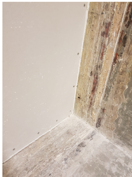
Figur 3.4: Applicerad fogmassa längd med kanterna.
