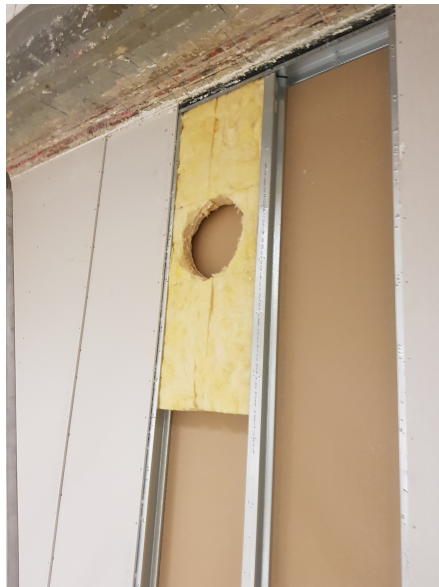
Figur 3.17: Placering av glasullsskiva för mätsekvens BA4.
