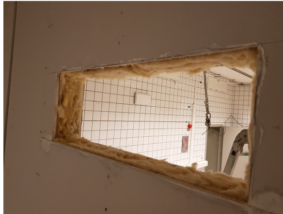
Figur 3.21: Glasull i vägg för kombination 52/700x250.
