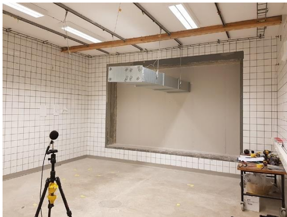
Genomföring av rektangulär kanal i vägg.
