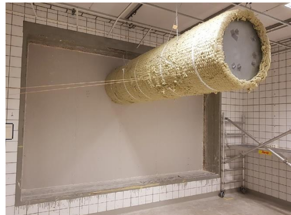
Genomföring av cirkulär kanal med dimension \varnothing 630 mm och svepning med 50 mm tjock stenull längs med hela kanalen på båda sidorna, densitet: 100 \text{ kg/m}^3 .
