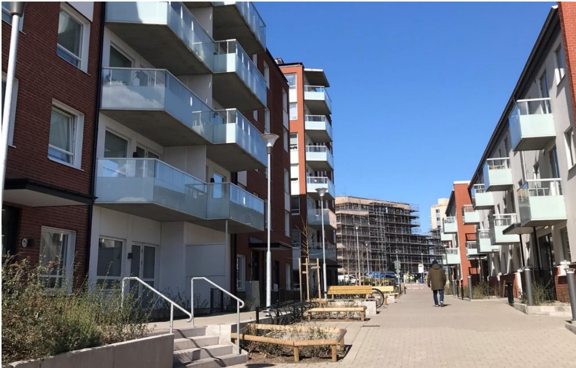
Bild 2. Drottninghög i förändring. T.v. nybyggda hus, t.h. renoverade hus. I bakgrunden skimtar ytterligare en nybyggnation. Fotot taget 30-03-2020 av Malin Andersson
