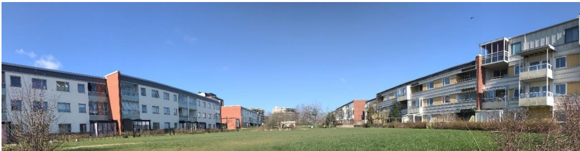
Bild 1. Bostadshus på Drottninghög. T.v. nyrenoverade lägenhetshus, t.h. ej renoverade. Fotot taget 20-03-2020 av Malin Andersson.
