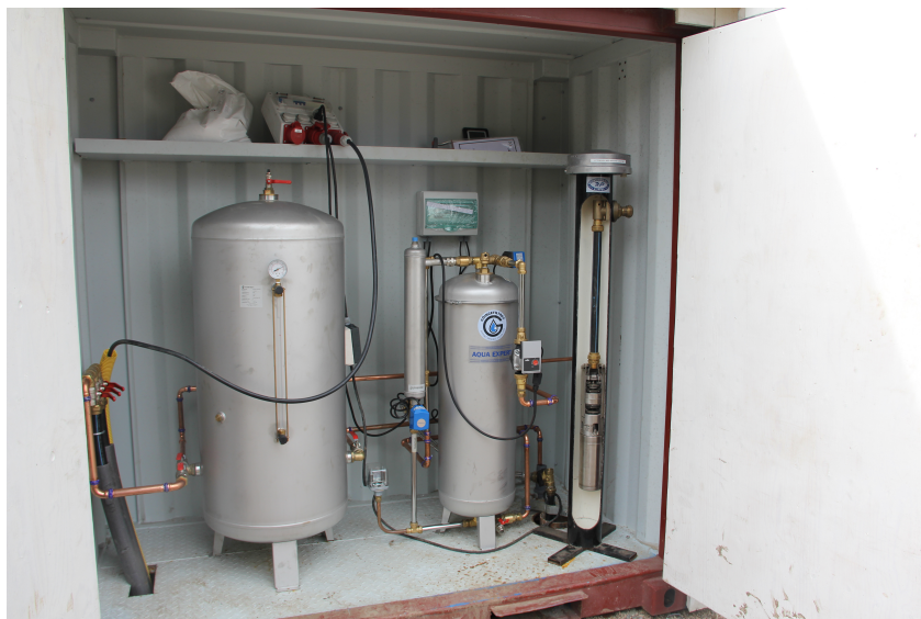
Figur 8 Inuti pumphuset på fastigheten Lilla Klåveröd. Från vänster: utgående markledning mot fastigheten, 300 liter rostfri hydrofortank, luftningsfilter Aqua Expert kombi 50 och modell i genomskärning på sänkpump. Modellen är framtagen för att åskådliggöra principen för frostfri installation i stålrör. Publicerad med tillstånd från Göran Persson.
