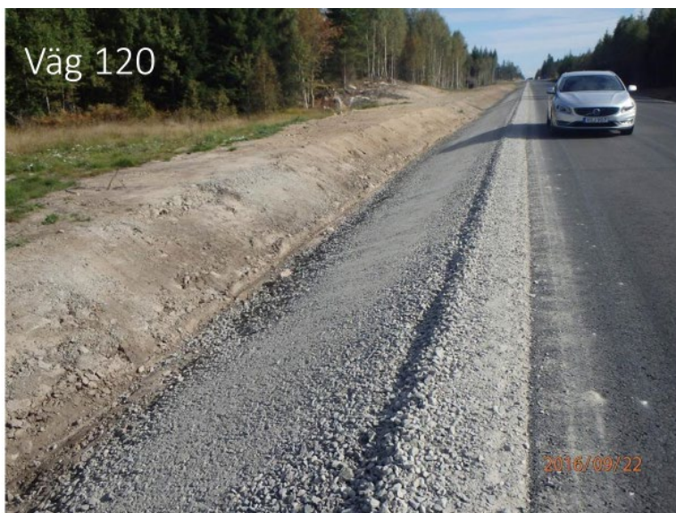
FIGUR 9 NYLAGD INNERSLÄNT MED BÄRLAGER I INNERSLÄNTER OCH TÄT STÖDREMSA (GUNNARSSON)
