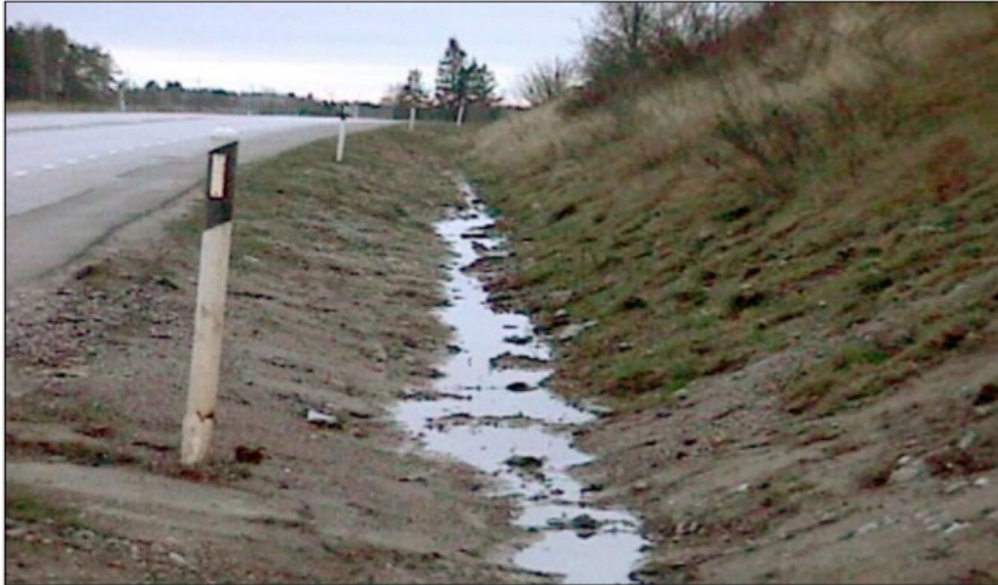
FIGUR 6 NAKET DIKE (VÄGDIKENAS FUNKTION OCH UTFORMNING, 2003)
