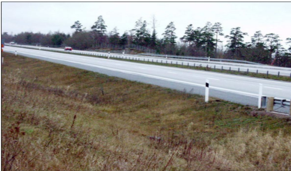
FIGUR 5 DIKE MED VÄXTBEKLÄDNAD (VÄGDIKENAS FUNKTION OCH UTFORMNING, 2003)
