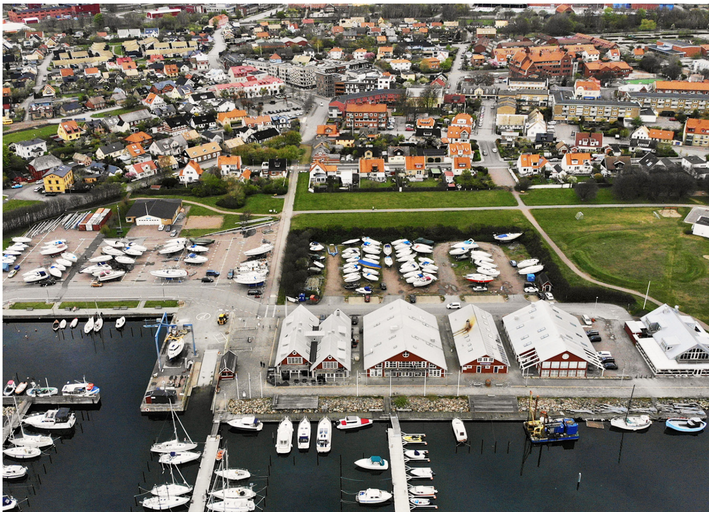
Småbåtshamnen. Småbåtshamnen har ett antal publika funktioner så som restaurang, frisör och kontor i fem röda sadeltaks byggnader. Dessa ligger längst ut på bryggans hamnpromenaden och kallas Höganäs Marina. Resten av småbåtshamnen består av asfaltsparkering för antingen bilar under sommaren och båtuppställning vintertid.
