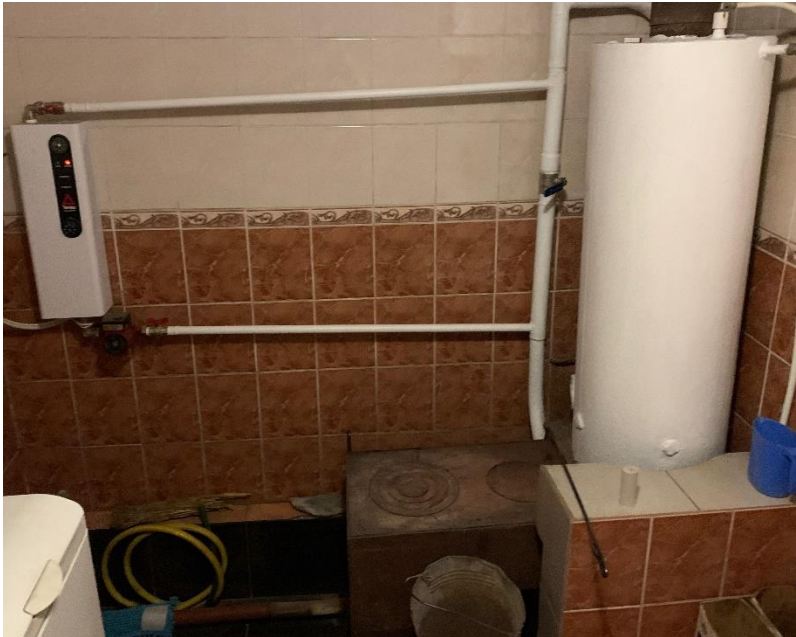
Figur 3.8: Byggnadens uppvärmningssystem, där varmvattentank och kamin syns.
