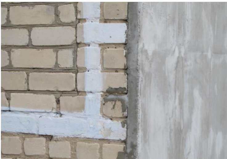
Figur 3.47: Tilläggsisolering av fasad där delar av fasaden har blivit isolerad med 5 cm cellplast.
