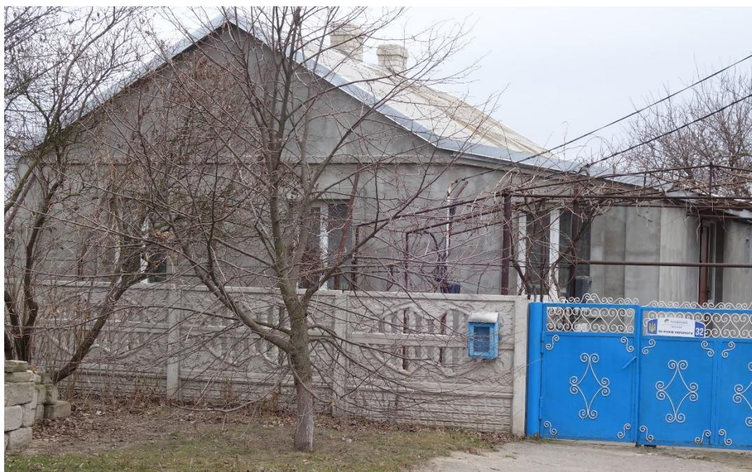
Figur 3.55: Byggnad P32, med antagande att stommen består av klinksten. Nyare fönster, antagligen från Steko. Fasaden ser ut att vara tilläggsisolerad, vilket syns av de mörkare fogarna på fasaden. Sadeltak.
