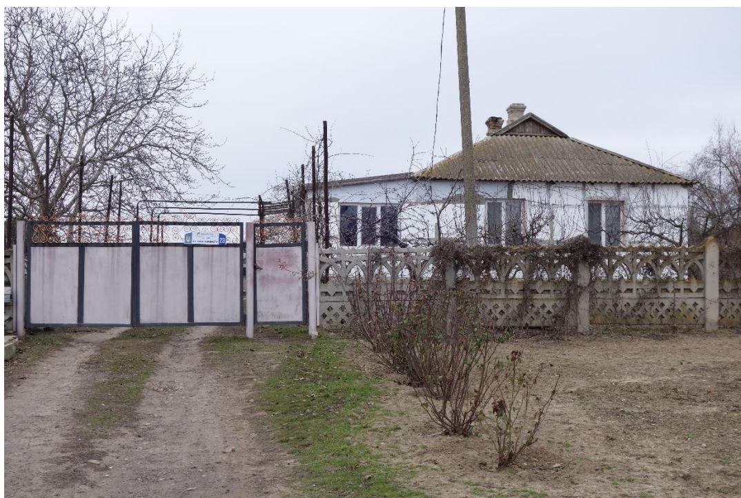
Figur 3.57: Byggnad P23, med antagande att stommen består av kримsten. Nyare fönster, antagligen från Steko. Fasaden ser ut att vara tilläggsisolerad. Valmat tak.
