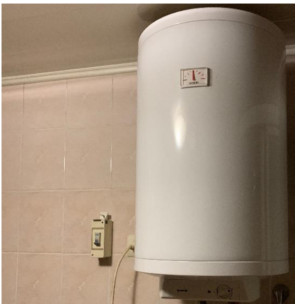
Figur 3.9: Varmvattenberedare
