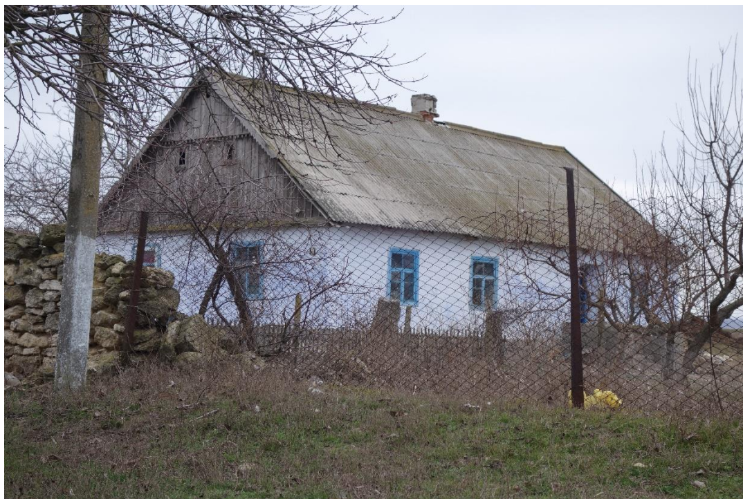
Figur 3.52: Byggnad S51, med antagande att stommen består av krimsten. Fönster ser ut att vara av äldre typ. Brant lutning på sadeltaket vilket medför att det finns plats för isolering på vinden.
