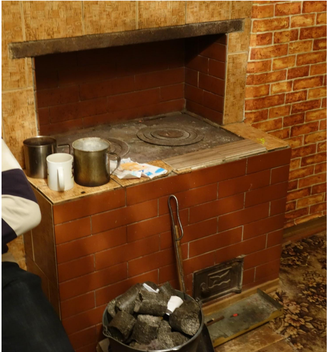
Figur 3.27: Kamin som används till uppvärmning. Briketterna som används syns även i nedre delen av bilden.
