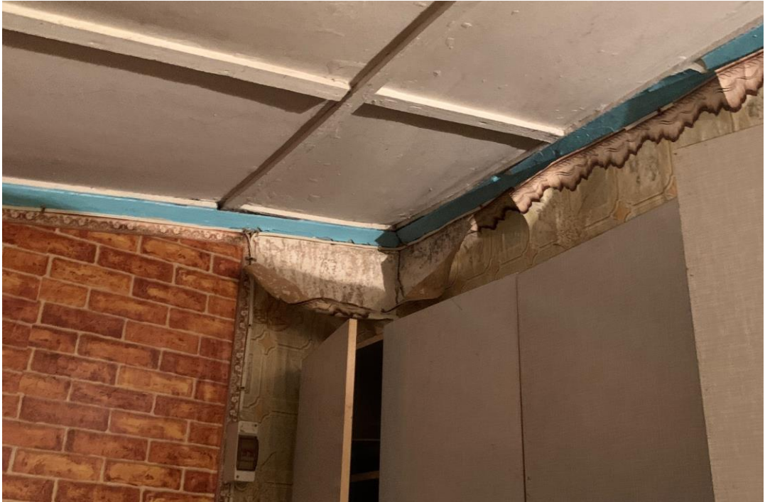
Figur 3.32: Innerväggens anslutning mot taket i entré/kök.
