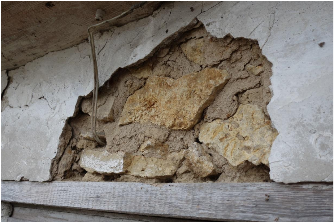
Figur 3.5: Vegg där materialet krimsten framgår. Bilden är tagen från ett annat hus än det i fall 1.
